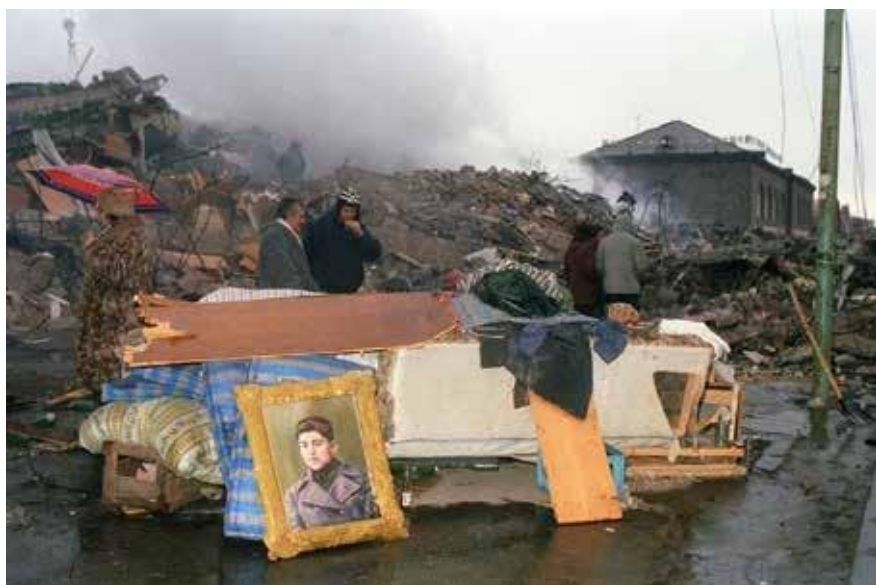
Рис. 123. Армения. Последствия землетрясения в городе Спитак. 1988.
